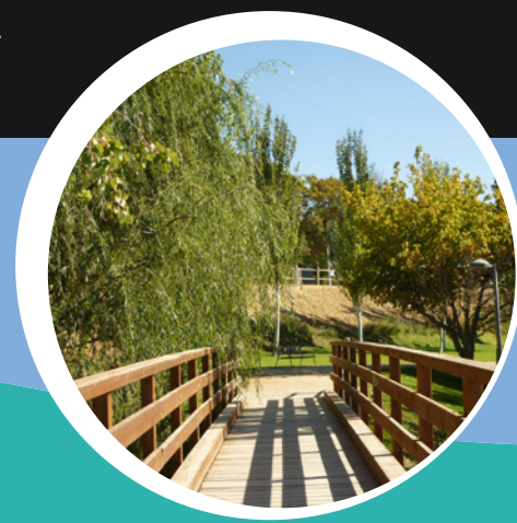
Pasarela sobre el Huerva
